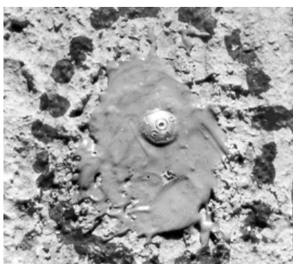
Φωτ.3 Σήμανση κορυφής κύριας όδευσης
