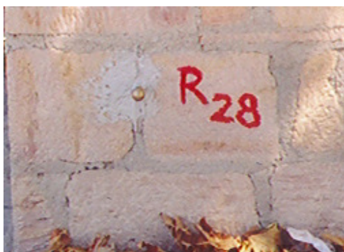
Φωτ.2 Ορειχάλκινη κατασκευή (μπουλόνι) για τη σήμανση υψομετρικής αφετηρίας (Rèpère)
